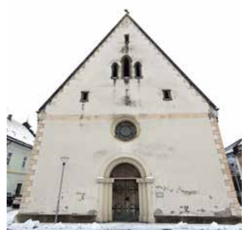
Auch die Fenster müssen renoviert werden
