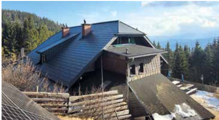
Das Oskar-Schauer-Haus erstrahlt in neuem Glanz
