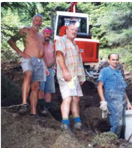
Wasserleitungsbau am Sattelhaus
